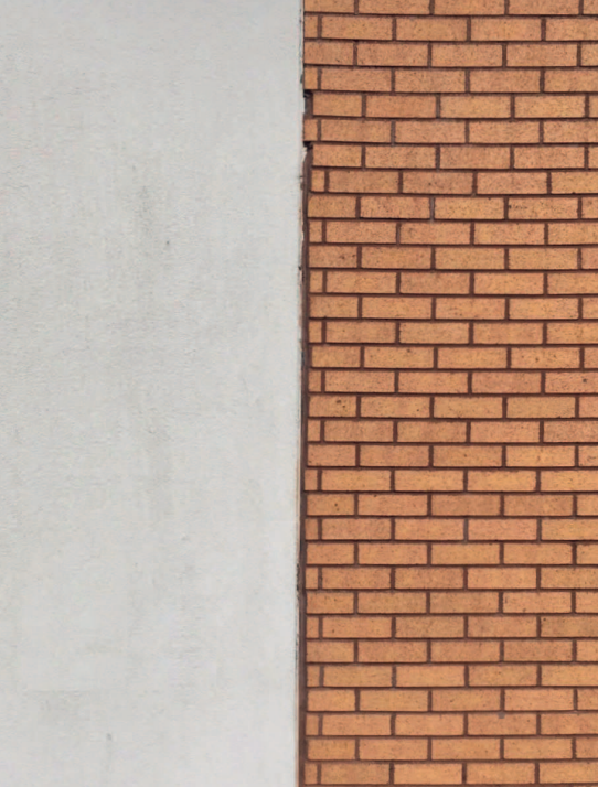
Wärmedämmverbundsystem mit Putz (links) und Klinkerriemchen (rechts).
