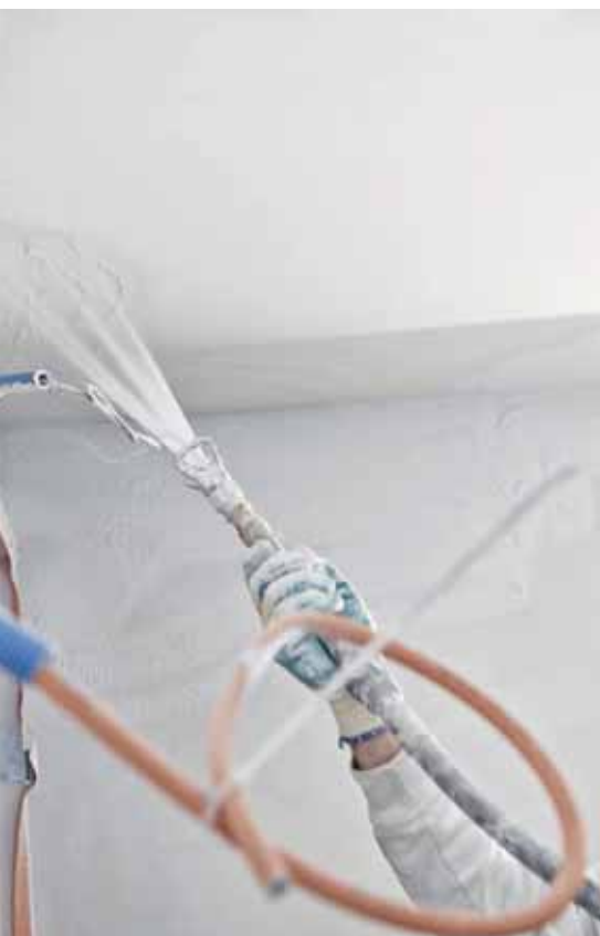
Das Spritzen von Weissputz ist die grösste Innovation im Innenbereich seit den 1980er-Jahren. (Bild: SMGV)
