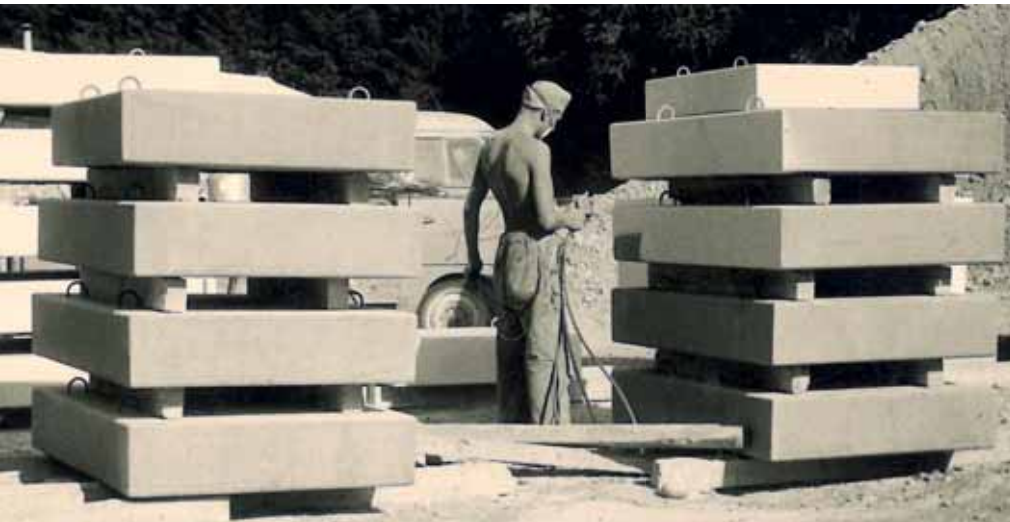
Bild aus einer anderen Zeit: Spritzverzinken mit nacktem Oberkörper im Freien.
