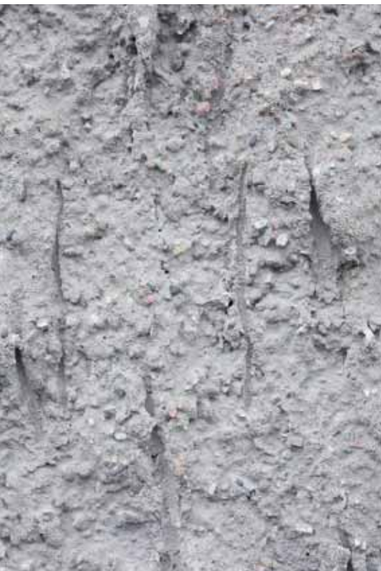
Deckputz Fassade, Batschenputz mit Kellenwurf überarbeitete Oberfläche abgesäuert.
