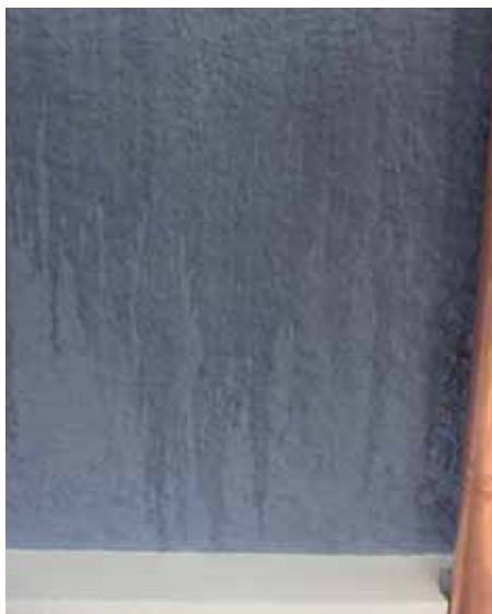
Sogenannte Schnecken- spuren nach Regen.
