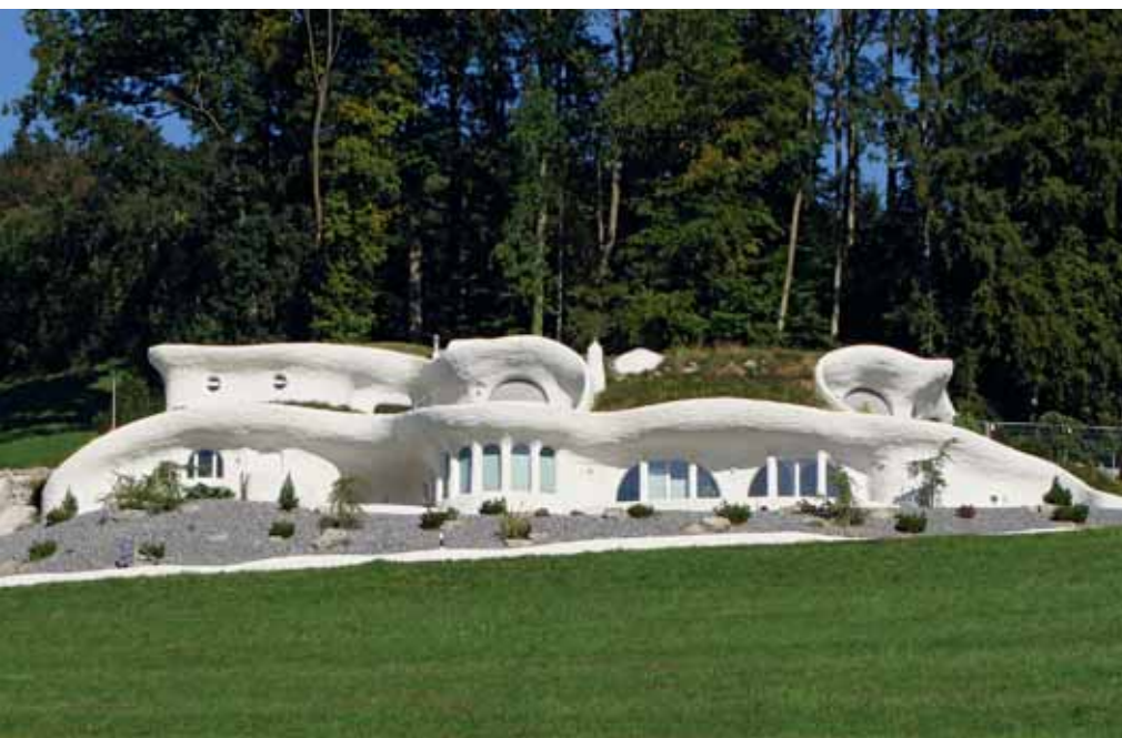
An diesem Gebäude ist eine Fassadenrenovation anspruchsvoll.
