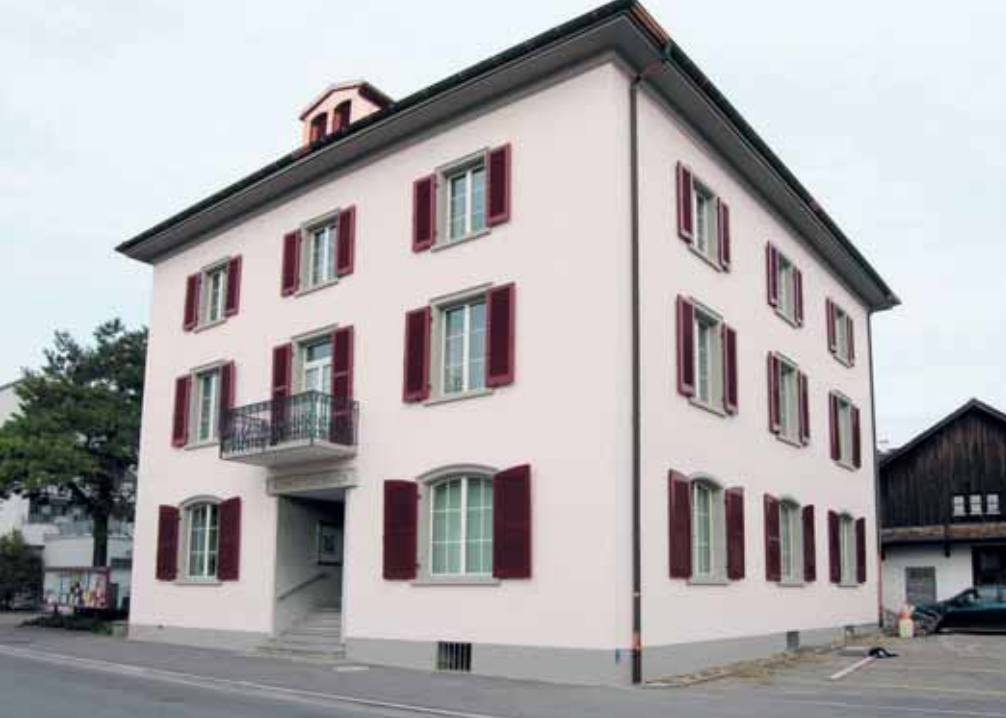
Fassadenbeschichtung mit Silikonharzfarbe.
