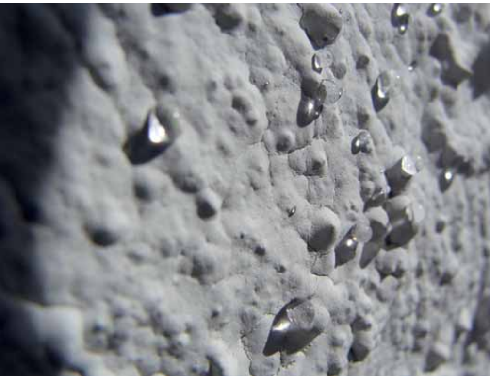
Schrumpfrisse in einem Neuanstrich mit funktionie- render Hydrophobierung.
