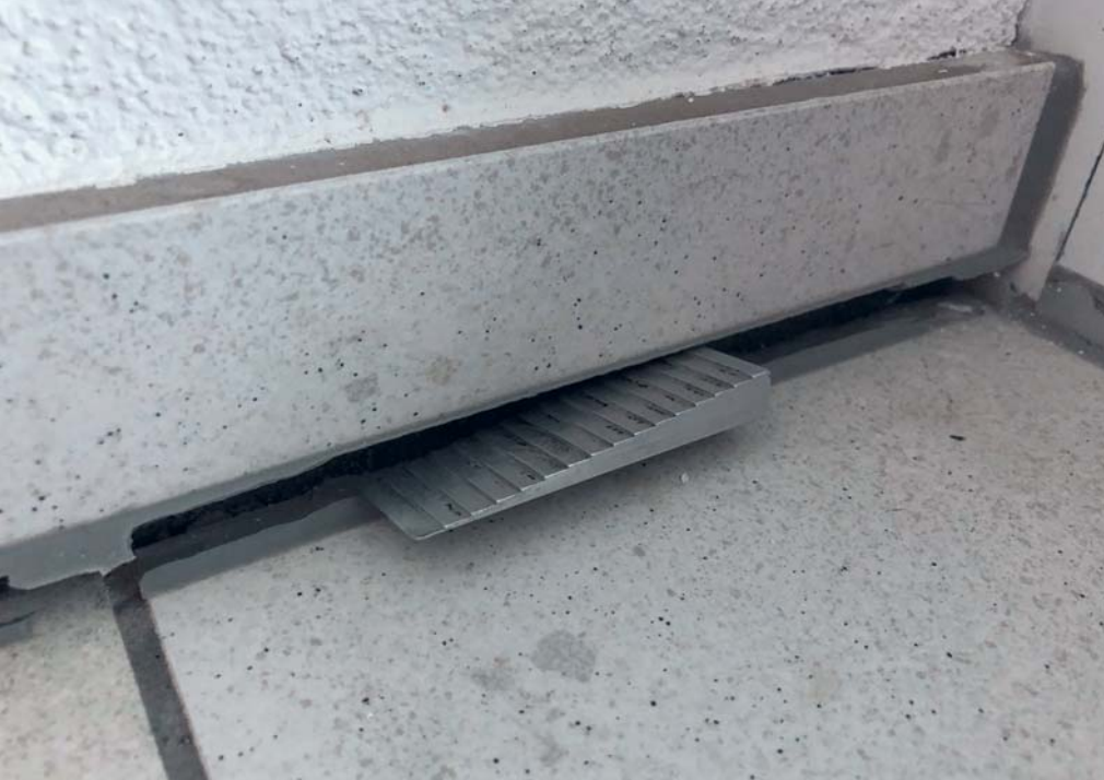
Abb. 15: Absenkung über 10 mm.
