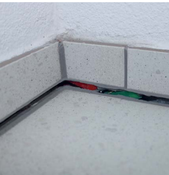
Abb. 12: Aufgerissene Fuge.
