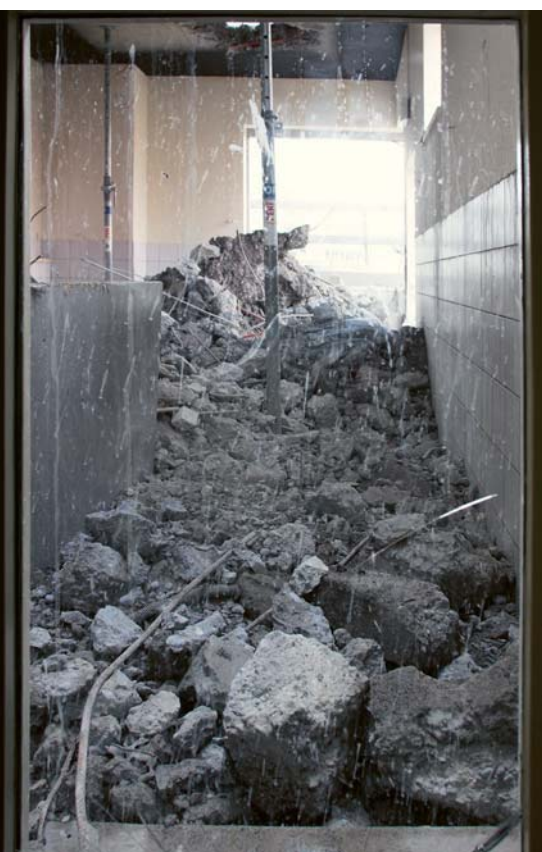
Der Betonabbruch machte einen Grossteil des Bauschutts aus. (Bild: Cornelia Sigrist)
