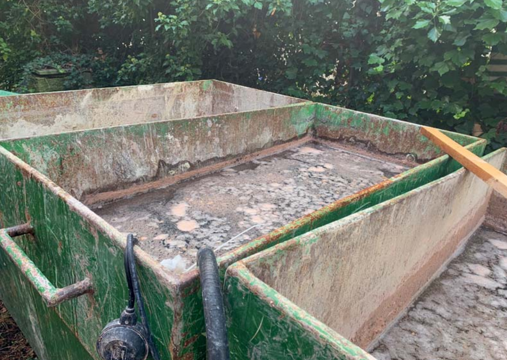
Die Mulden für das Schmutzwasser fassen je 1000 Liter.
