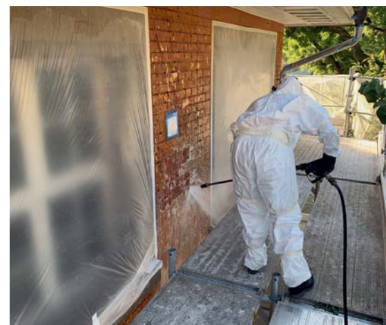
Der Abbeizer wird mit dem Heisswasser-Hochdruckreiniger abgewaschen.
