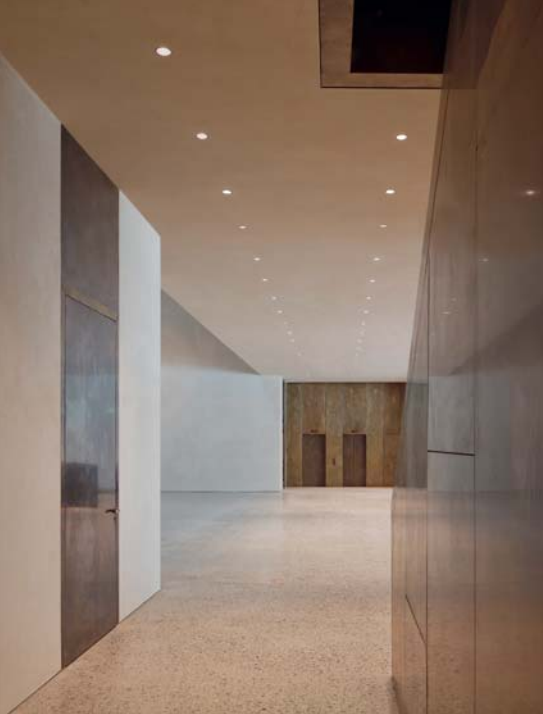
Die Gipser putzten 1200 Leuchten ein. (Bild: Hanspeter Schiess für Cukrowicz Nachbaur Architekten)
