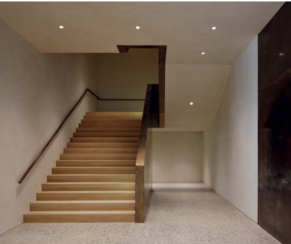
Der Lehm-Edelputz wurde zweimal mit Japanglättkellen aus rostfreiem Edelstahl geglättet. (Bild: Hanspeter Schiess)
