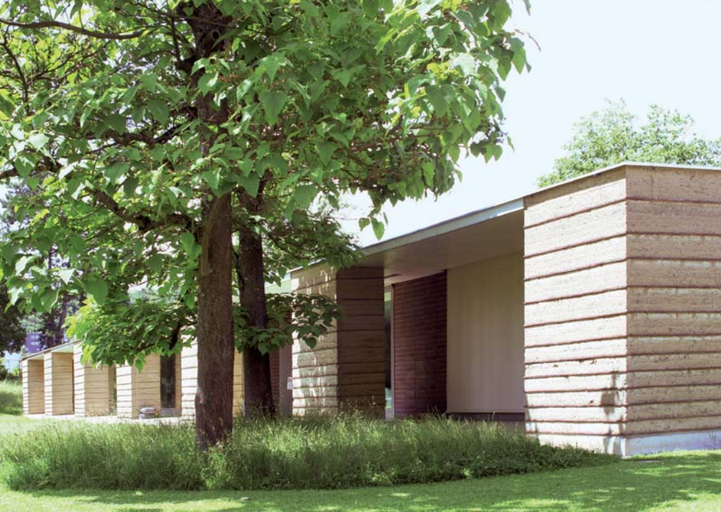
Boltshauser Architekten bauten ein Schulgebäude von 1958 mit viel Lehm zum Hort um. (Bild: Achim Pilz)
