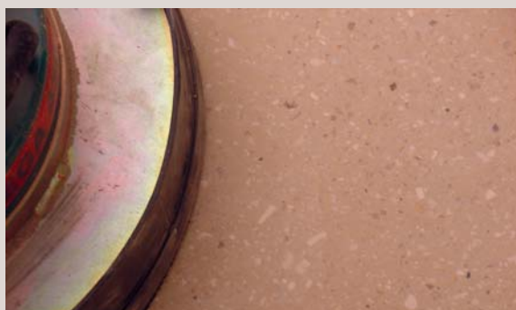
Ein Lehmterrazzo wird mehrfach geschliffen und schliesslich mit Tiefgrund, Öl und Wachs eingelassen. (Bild: Claytec/Willhardt)
