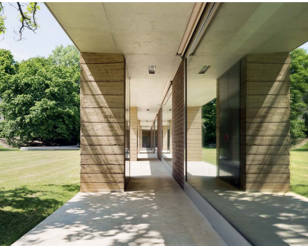
Der Stampflehm der Veranda gestaltet den Übergang zwischen dem Gebäude und der Natur. (Bild: Boltshauser Architekten)
