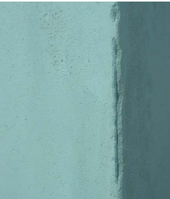
Scharfe Kanten in Lehm sind empfindlich. (Bild: Achim Pilz)
