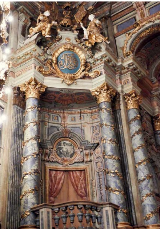
Virtuose Malerei auf mit Leinwand bespanntem Holz in einer Trompeterloge (Bild: Alexandra von Ascheraden)
