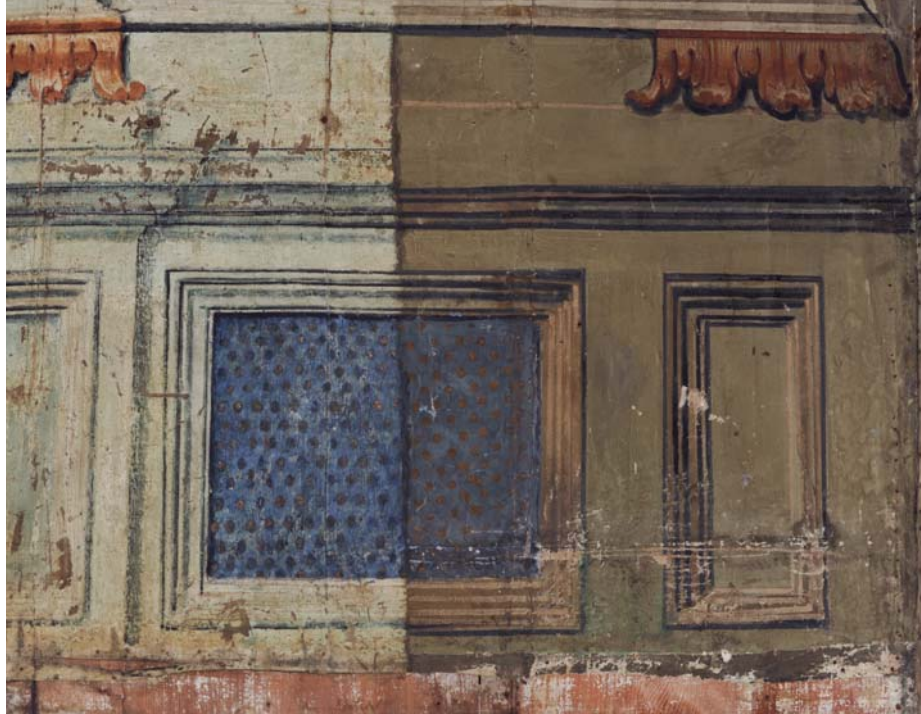
Fürstenloge (innen) Nord-west, in Höhe des 1. Rangs: Zustand während der Konservierung (Malschichtfestigung, Abnahme der Übermalungen, Überzüge und Retuschen). Die linke Seite im Bild ist bereits bearbeitet. (Bild: Melissa Speckhardt, © Bayerische Schlösserverwaltung)
