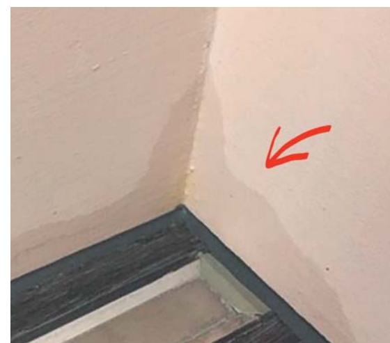
Fugenlose Wandbeschichtung mit optischem Mangel wegen Feuchtigkeits-hinterwanderung.
