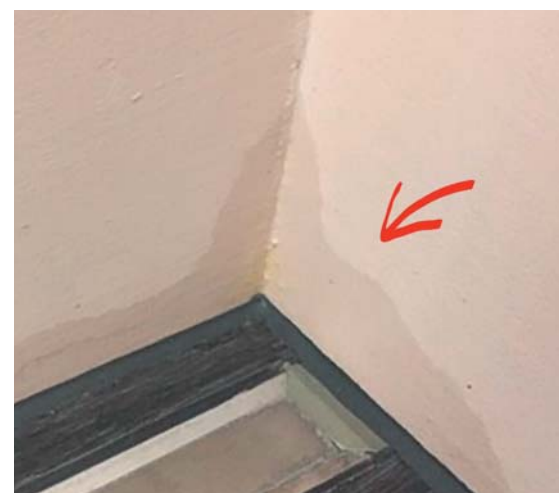
Fugenlose Wandbeschichtung mit optischem Mangel wegen Feuchtigkeits-hinterwanderung.
