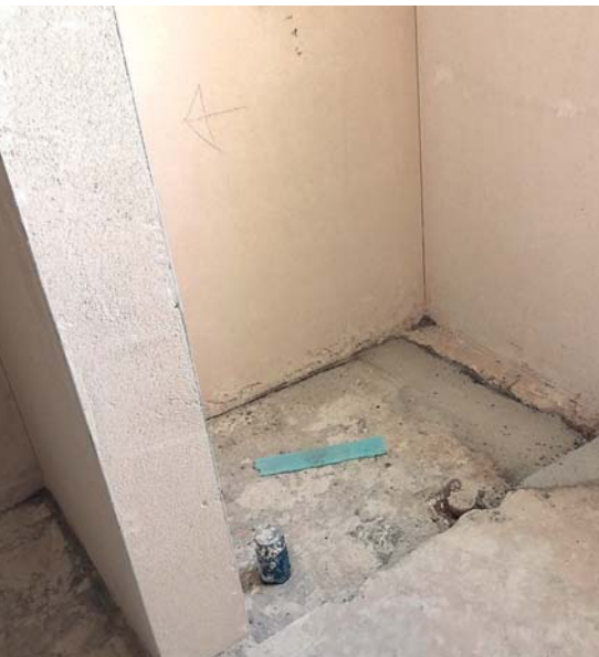
Der im Umbau des SMGV verwendete Grundputz ist ein neuartiger Weisszement-Grundputz. (Bild: Christoph Fontana)
