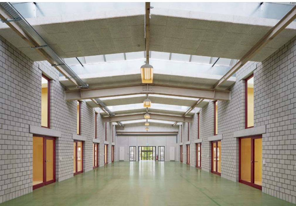
Zwischen den Ateliers befindet sich die Verbindungszone mit einem neuen Anhydritboden. (Bild Tom Bisig)
