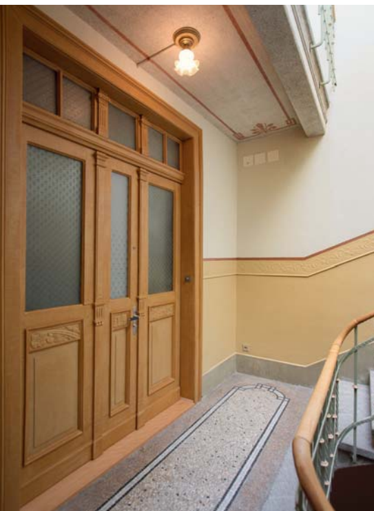
Der Bereich oberhalb des Wandsockels im Treppenhaus ist mit Linkrusta, einer Leinöltapete, gestaltet. Diese galt es teilweise zu ergänzen.
