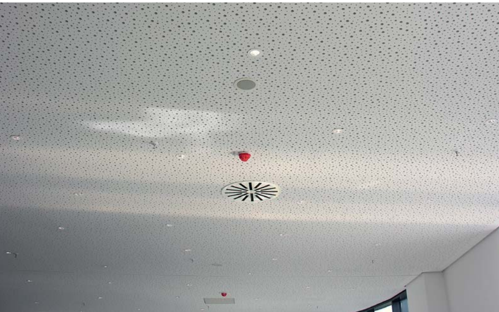
Durch das Ergreifen raumakustischer Massnahmen wie den Einbau spezieller Decken mindert sich die Unruhe im Klassenzimmer. (Bild: Knauf)
