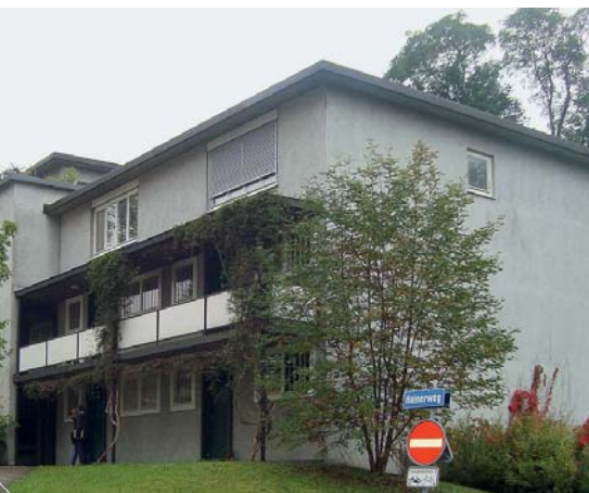
Die Dämmung der Gebäudehülle ist eine Massnahme neben der Optimierung von Wärmeerzeugung und Stromeffizienz. (Bilder: oben Andreas Edelmann, unten Nina Mann)
