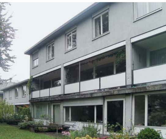
Balkonfassade des Mehrfamilienhauses Billrothstrasse 14/16 in Zürich vor und nach der Sanierung. (Bilder: oben Andreas Edelmann, unten Nina Mann)
