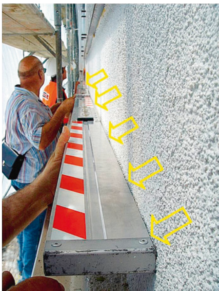
Kontrolle der Ebenheit einer wärmege- dämmten Fassade mit einer 4 Meter langen Richtlatte.
