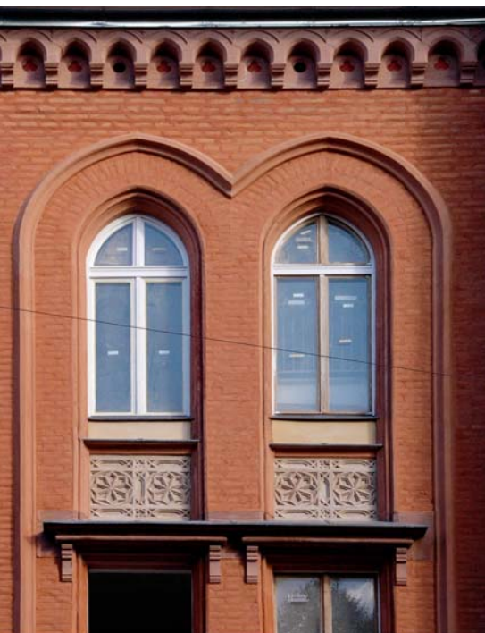
Bild oben: Leibung, Umrahmung und die ausgebesserten Elemente unter den Fenstern bilden eine stimmige Einheit.
