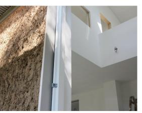
Nach der Trocknung des Leichtlehms wird dieser mit Kalk verputzt.
