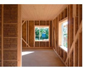
In die vorgefertigten Innenwände wurden schwere Lehmsteine trocken gestapelt.
