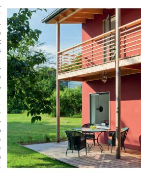
Luftdicht, diffusionsfähig und kapillaraktiv ist die Fassade aus Lehmschale, Kalkputz und Silikatfarbe. Der erdige Vollton der Fassade passt gut zum Wandaufbau. (Bild: Thomas Ott,
