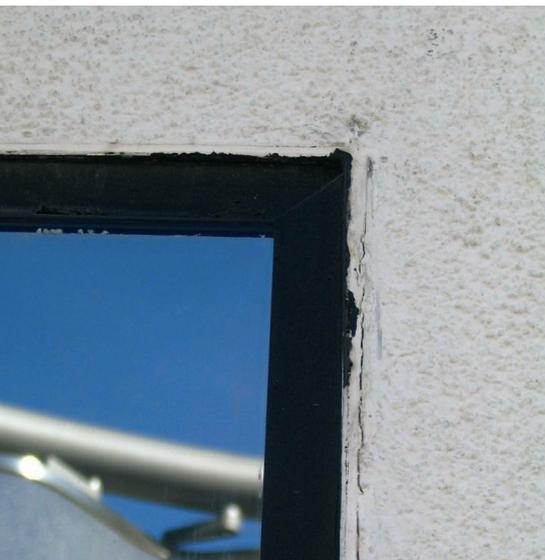
In der Putzebene abgerissener Fensteranschluss mit versprödeter Dichtstoffanschlussfuge.
