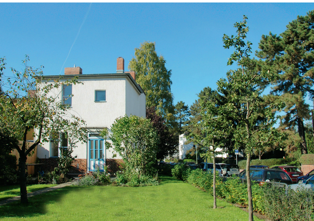
Das Eckhaus in der Berliner Hufeisensiedlung ist heute ein Ferienhaus, in dem die originale Farbgestaltung von Bruno Taut erlebt werden kann.
