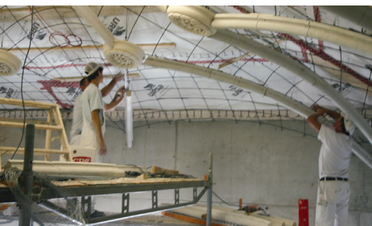
Die Sternenkuppel im Wellness-Ruheraum des Hotels Santa Isabel in fertigem Zustand (grosses Bild links) und während der Entstehung (kleines Bild).
