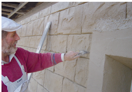
Kulissenbau mit modernen Anforderungen wie Wärmedämmung: Kratzen von Steinmauerwerk (links) an einem Turm (unten).
