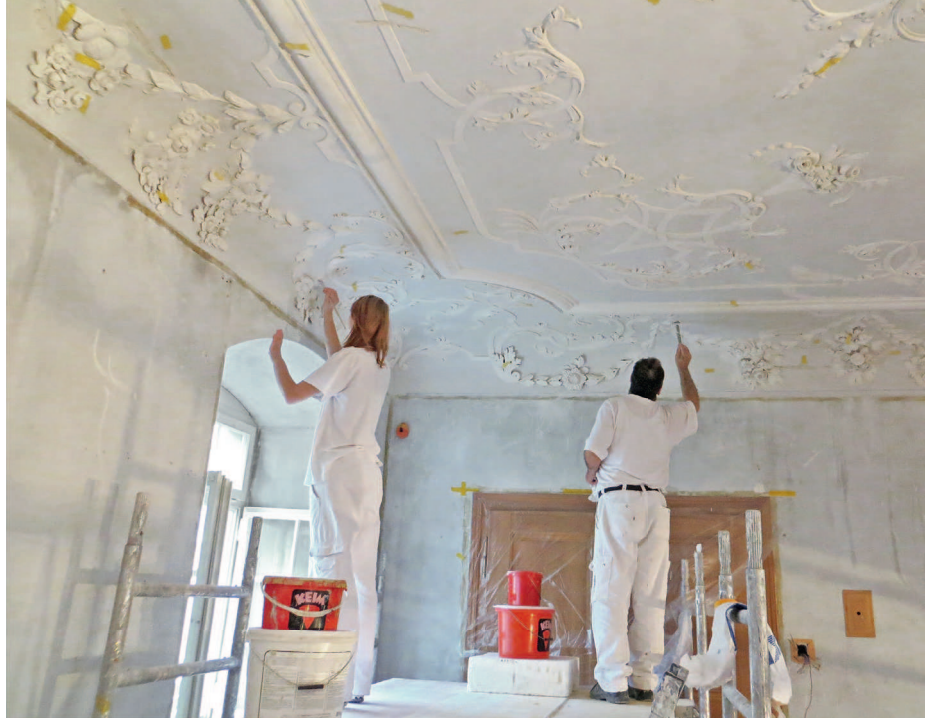
Renovation des Empfangssaals im Klosterhof. (Bild: Denkmalpflege Stadt St.Gallen)
