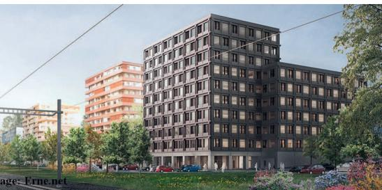
Bilder oben und rechte Seite: Das erste Hochhaus mit einer Tragstruktur aus Holz steht im zugerischen Risch Rotkreuz. Weil eine nicht brennbare Bauteiloberfläche gefordert wird, kommen auch Gipsplatten zum Einsatz.
