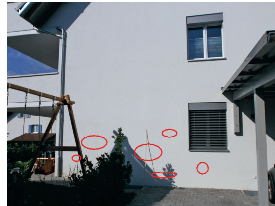
Bild 6: Die Gesamtschichtdicke (inkl. Deckputz) an der Probeöffnung beträgt max. 10 mm.
