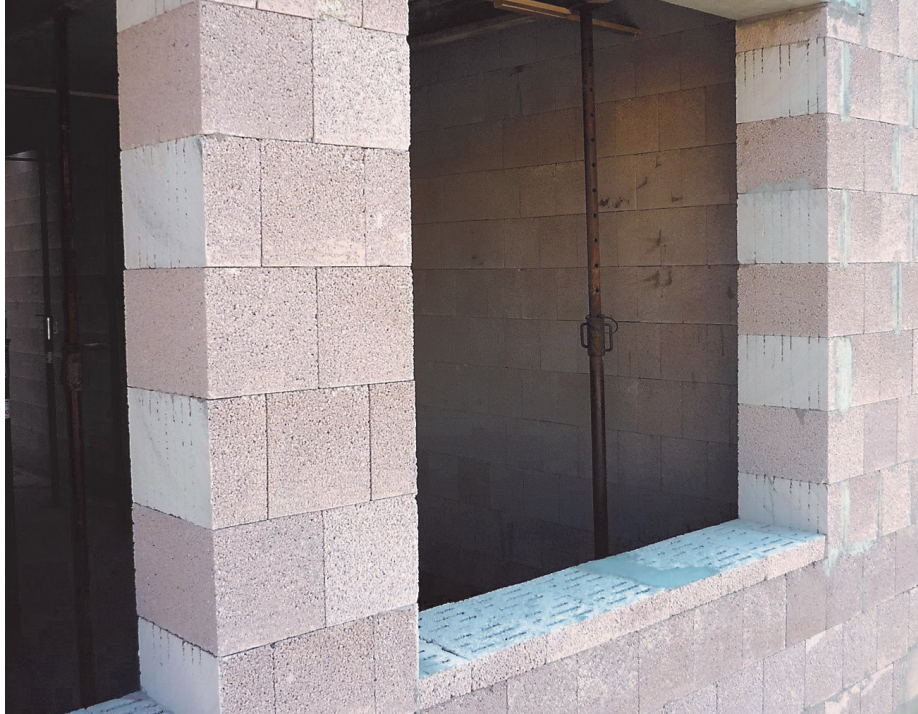
Bild 8: Plansteinmauerwerk. (Bild: Bisotherm GmbH, Mülheim-Kärlich)
