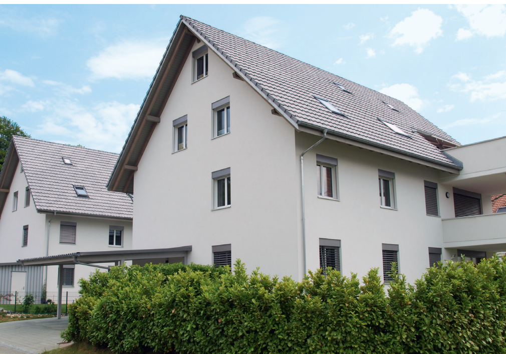
Bild 1: Die Fassadenflächen sind grundsätzlich durch einen guten Witterungsschutz geschützt.
