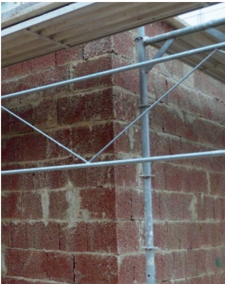
Bild 9: Rohbau (Bildquelle: A. Zimmermann, Stockwerkseigentümer)
