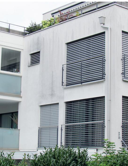
Bei dieser Ansicht eines Teilbereichs kann man die langfristige Wirkung des konstruktiven Witterungsschutzes erkennen, auch wenn er nur minimal ist. (Bild: Walter Schläpfer)
