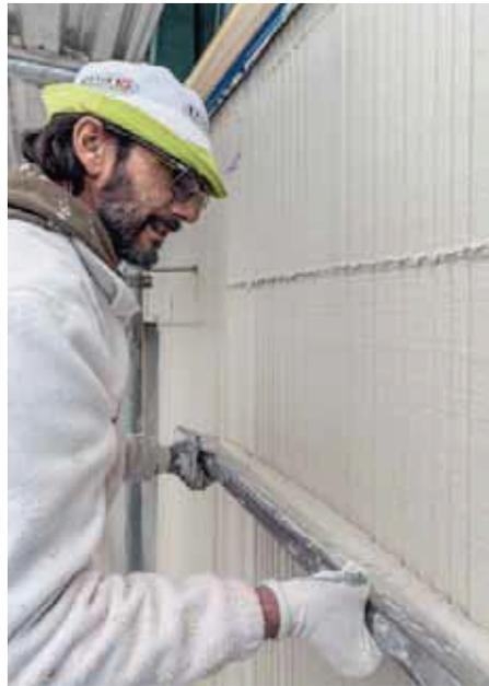
Die in einem 30-Grad-Winkel rückspringende Fassade bedingte besondere Arbeitsabläufe beim Modellieren des Verputzes.
