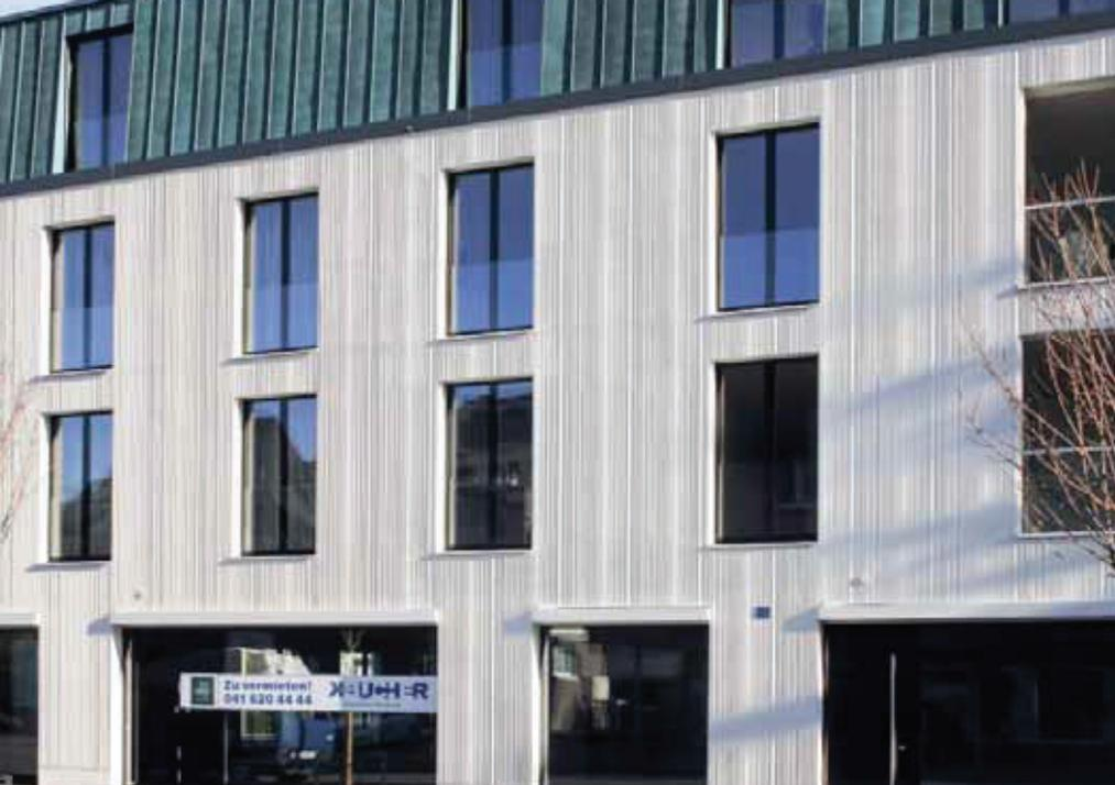
Die Frontfassade zeigt das spezielle Muster der spitz zulaufenden Mörtelstege.
