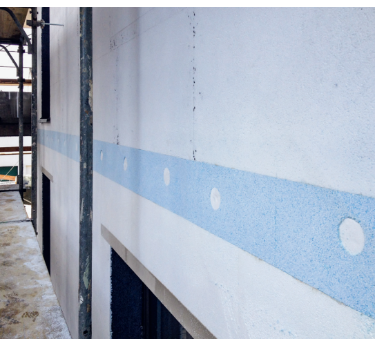
Eingebauter Brandriegel.
